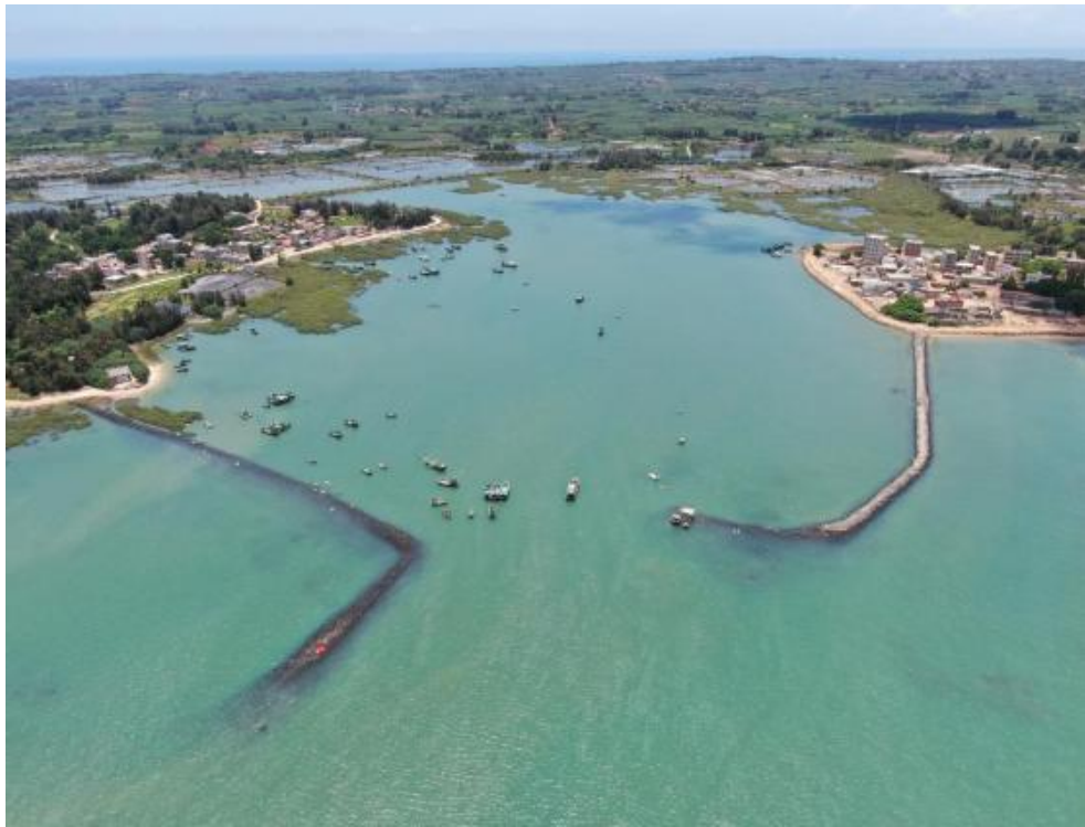
图 2-28 硇洲中心渔港（北港）现状照片
