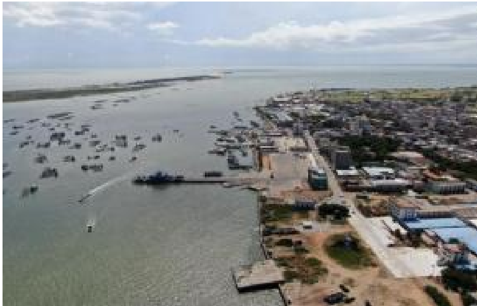
图 2-31 东南渔港现状照片
