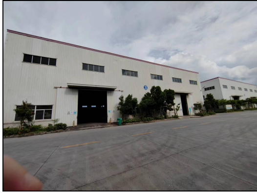
图 1：事故库房外部环境
