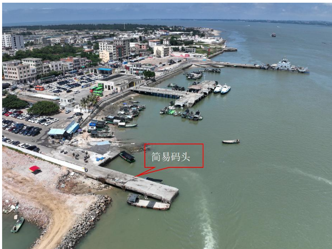
图 3.1-3 东南渔港现有简易码头现状情况图
