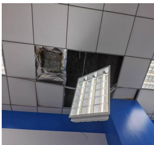
图 4（2）：吊顶脱落
