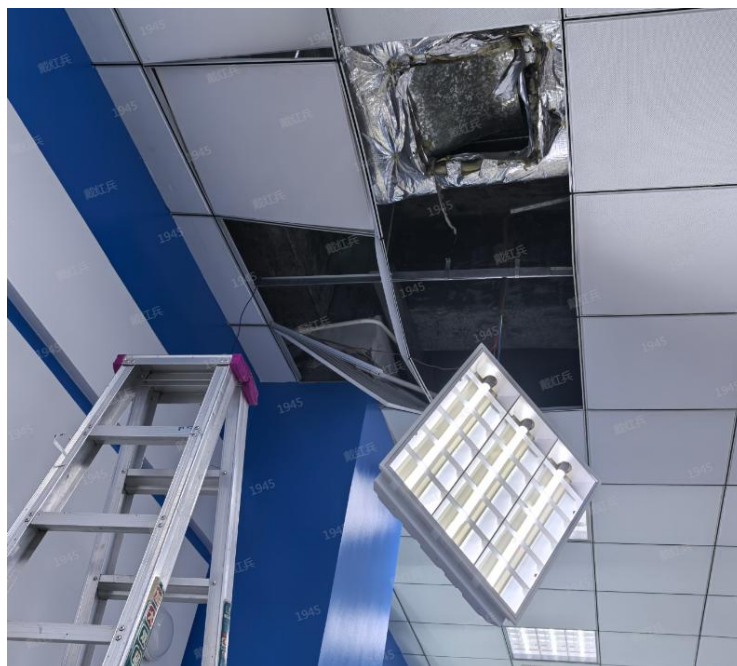
图 4（1）：吊顶脱落
