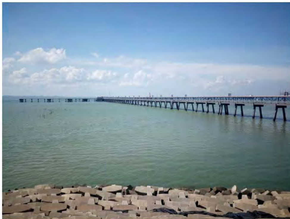
图 5.3-7 湛江液化石油气（LPG）冷冻储库及配套码头照片
