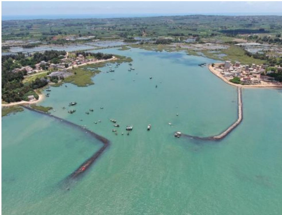
图 2.6-12 硇洲中心渔港（北港）现状照片
